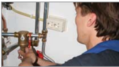
SpiroTrap und SpiroVent serienmäßig an jedem Heizkessel.
